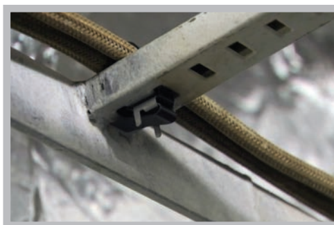
2. Fleje recubierto instalado en bandeja para cable antes de cerrar las orejas de la hebilla.
